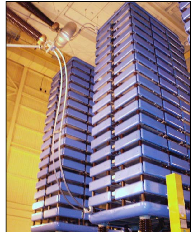
Gesteuerte Gleichrichtertürme bestehend aus je 96 Thyristoren für 250 kV und 2000 A
