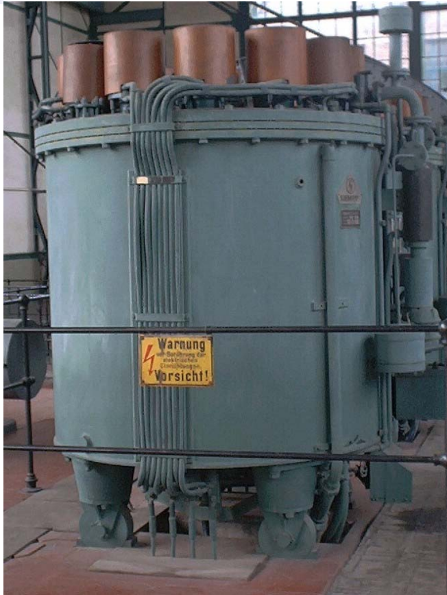
Quecksilberdampfgleichrichter von Siemens, für 560 V 1330 A
